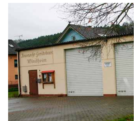
Wird winterfest: Das Windheimer Feuerwehrgerätehaus. Foto: Steffen Schreck
